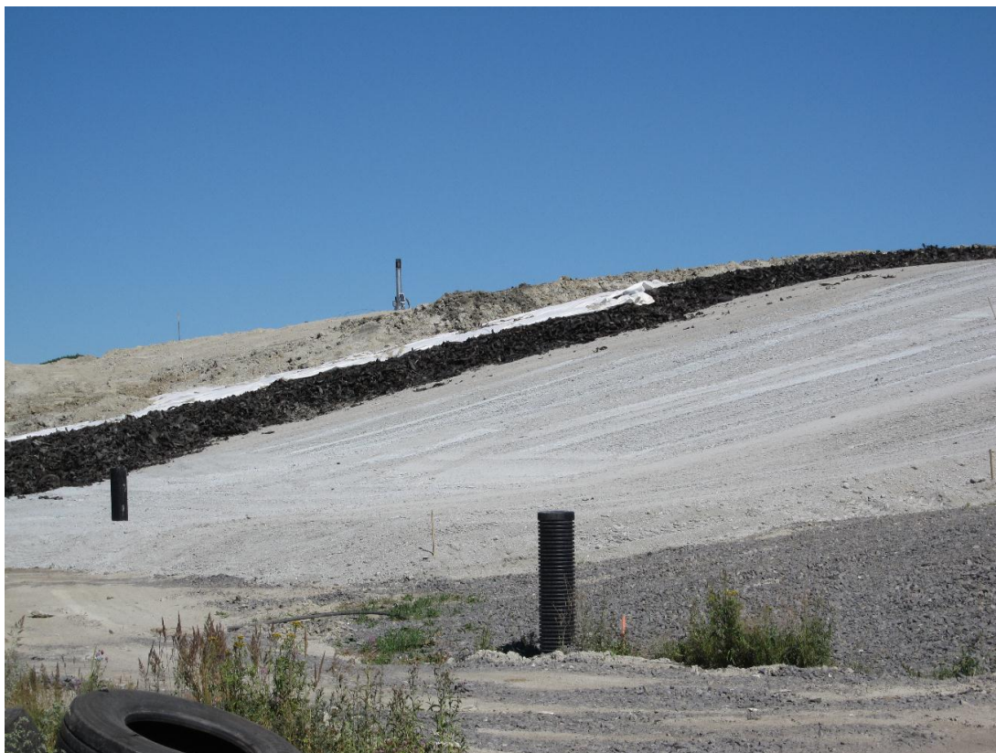
Kuva 9. Kuivatuskerros toteutettuna Rengasrouheella suljettavalla kaatopaikalla osana pintarakennetta.
