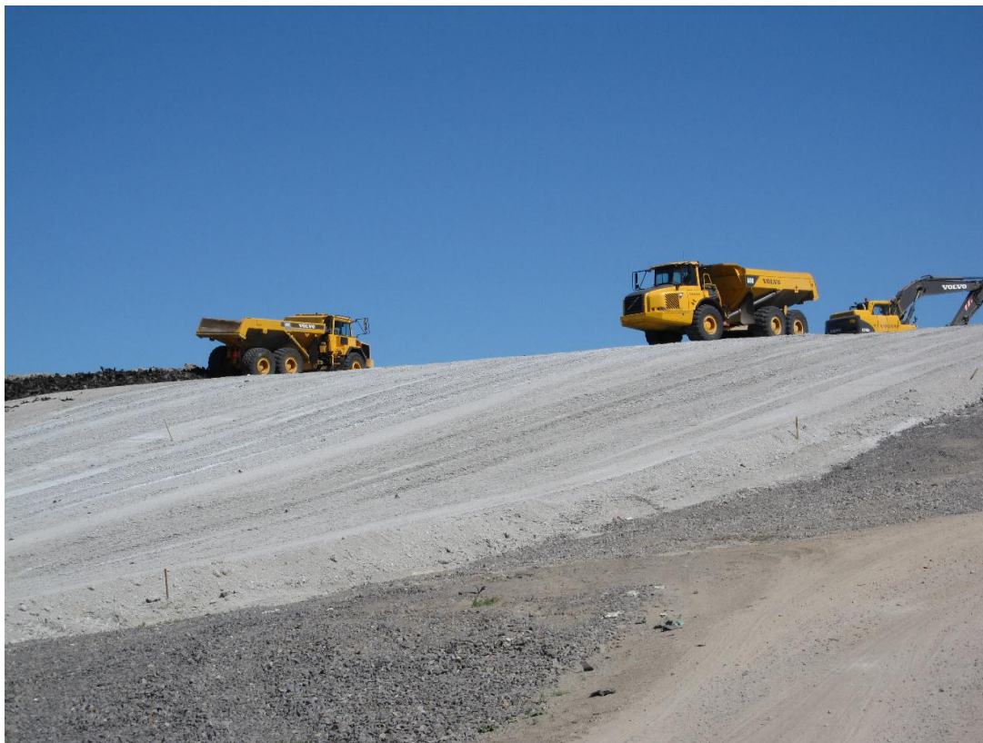
Kuva 5. Rengasrouhekerroksen rakentamista kaatopaikkatyömaalla.
