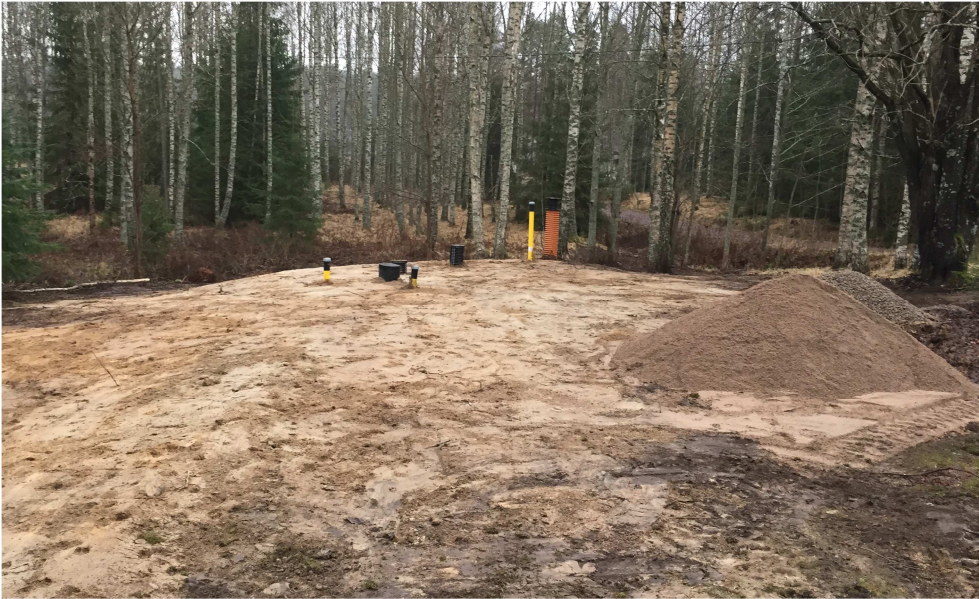
Kuva 5. Järjestelmä maahan kaivettuna. Etummainen musta putki on jakokaivo, kaksi taaimmaista mustaa putkea ovat 1. ja 3. biomoduulin viereen asennetut maaperän tarkastuskaivot. Keltaiset putket ovat kokoomaputkiston tuuletusputkia, ja taaimmaisina oranssi putki on kokoomakaivo.
