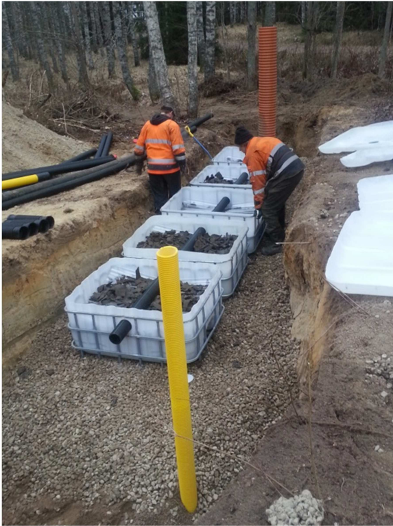
Kuva 2. Biomoduulit asennusvaiheessa. Kuvassa näkyy jakoputki jota pitkin vesi jakautuu, jakolevyjen kautta, tasaisesti moduuleille.
